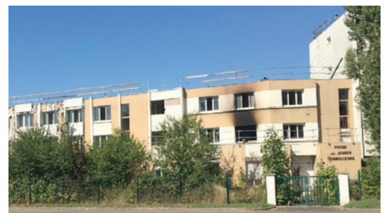
Démolition de l'ancien foyer jeune travailleur « Les Montoires » à Gien
