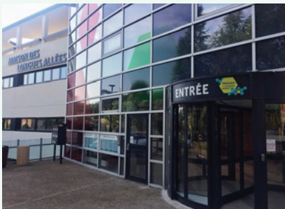
Maison de santé des Longues Allées à Saint-Jean-de-Braye, inaugurée le 30 juin 2018
